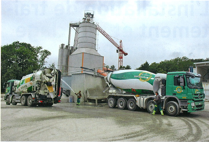
GCM a investi au service de l'environnement vaudois dans une installation de recyclages des matériaux pierreux et bitumineux de déconstruction
